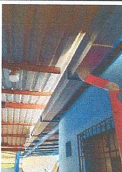
Foto 3: Canales y bajadas de agua pluvial.
