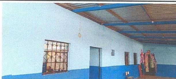
Foto 5: Así se ve el módulo rehabilitado.
