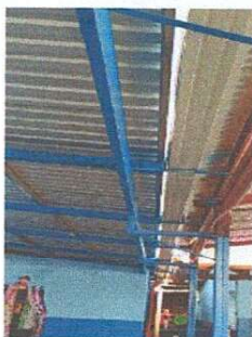
Foto1: Colocación de canales para agua pluvial
